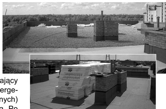
Stropodach ocieplony płytami Steinodur® PSN LD
