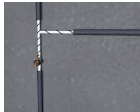
▲ Ułożenie przewodu na rurach wodociągowych
