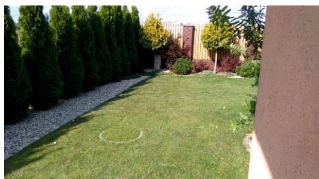
Oczyszczalnia z pokrywą KAMELEON wkomponowana w trawnik
