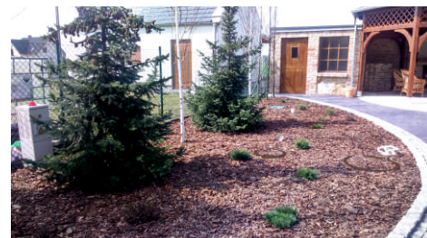
Oczyszczalnia SBR Primo+ z pokrywami KAMELEON wkomponowana w kory
