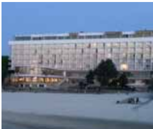
Sanatorium „BAŁTYK”, Kołobrzeg
