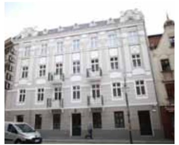
Hotel „Kamienica”, Opole
