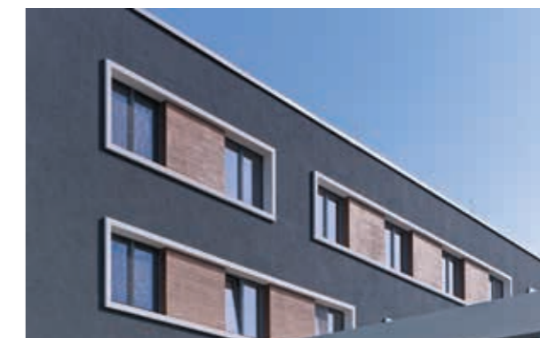
Farba StoColor X-black z refleksją ciepła znosi ograniczenia w wyborze kolorystyki. Nawet intensywne kolory do czarnego włącznie mogą być bezpiecznie stosowane na ocieplonej elewacji.
