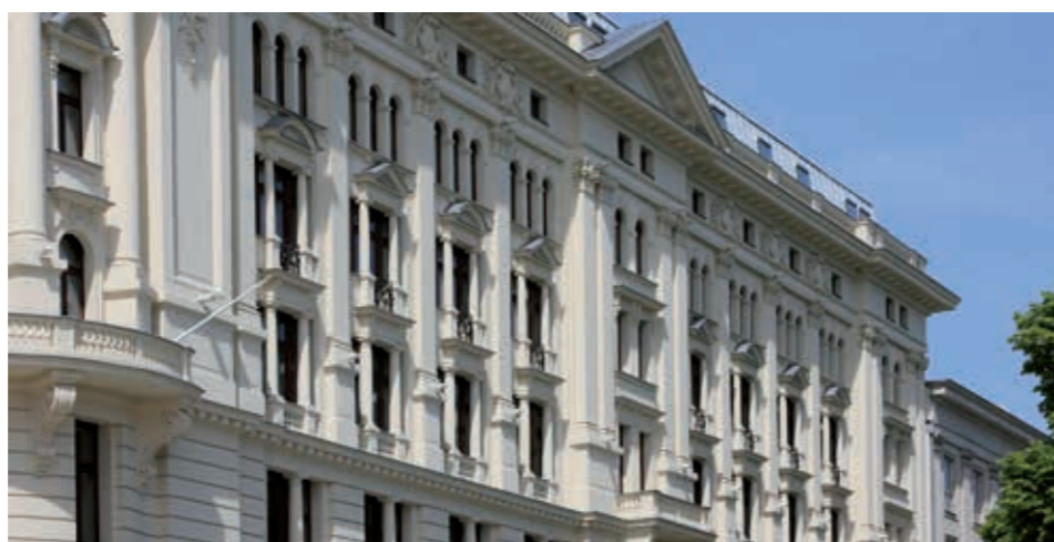
Obróbka wstępna z zastosowaniem preparatu Sto-HydroGrund zmniejsza nasiąkliwość podłoża i zapewnia elewacji wytrzymałe i stabilne podłożo. (Hotel Bristol, Warszawa)
