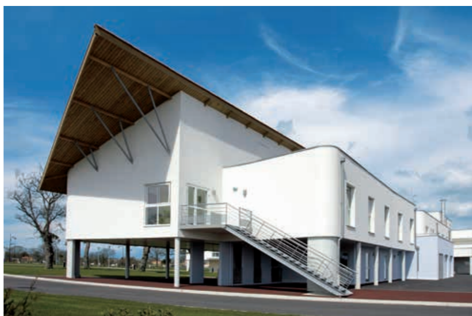
Dobrze wykonane gruntowanie reguluje nasiąkliwość elewacji, dzięki czemu doskonale przygotowuje ją do wykonania powłoki końcowej. (Hospital Intercommunal du Pays de Retz, Francja)
