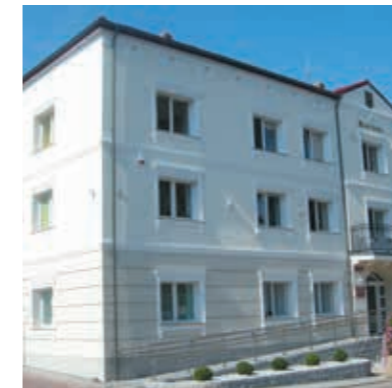
Profile StoDeco na elewacji ocieplonej systemem StoTherm Classic (Ratusz, Bobolice)
