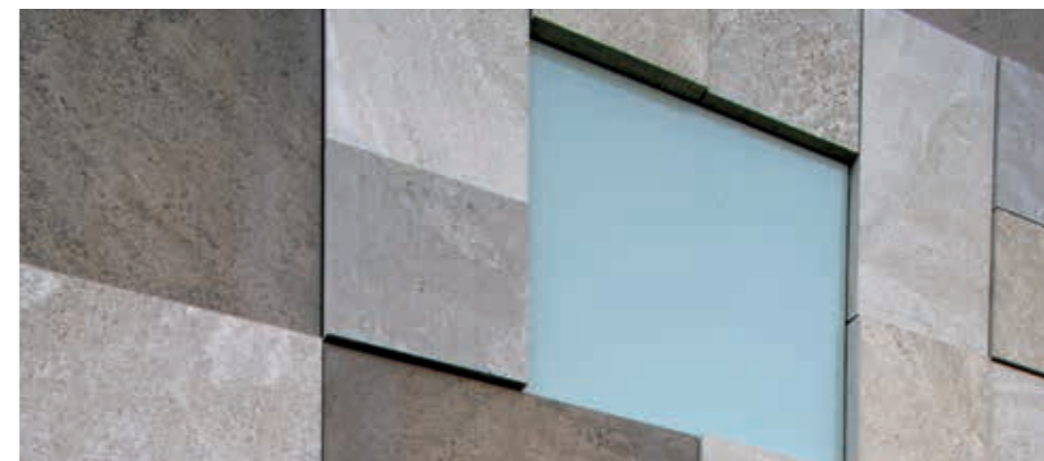
Niezwykłe rozwiązania: podwieszany, wentylowany system panelowy StoVentec umożliwia połączenie na elewacji nawet kamienia ze szkłem.
