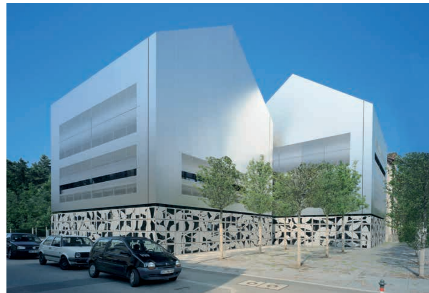
Przyszłościowo i wydajnie: trudno odgadnąć, że pod tą futurystyczną fasadą kryje się izolacja cieplna z wełny mineralnej StoTherm Mineral. (Südwestmetall Reutlingen, Niemcy)
