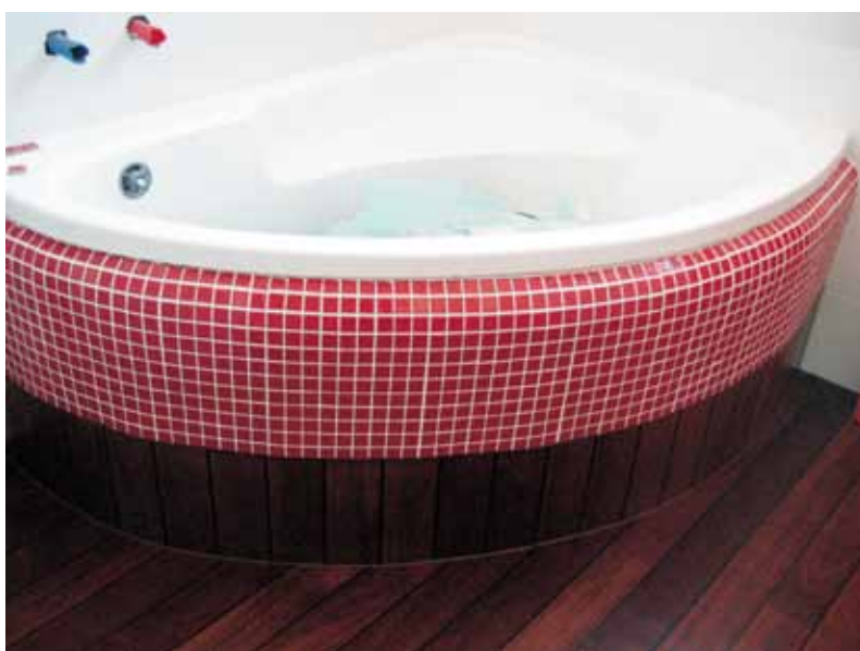
Następnie uzupełniamy fugi i kończymy obudowę wanien okładając bloczki YTONG dowolnie wybranym materiałem
