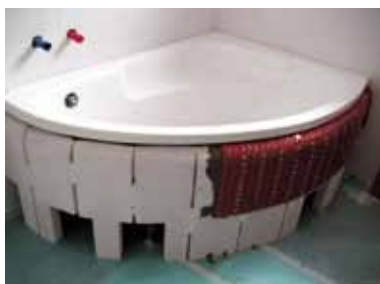
Teraz możemy przykleić glazurę bezpośrednio do powierzchni bloczków YTONG
