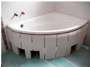
Potem szlifujemy je do półokrągłego kształtu.
