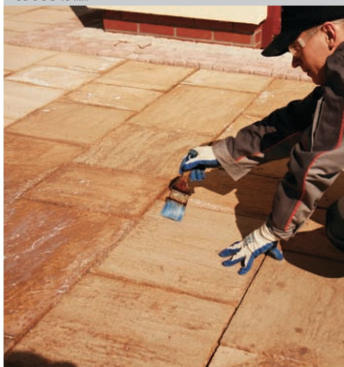
IMPREGNACJA PŁYT LIBET IMPREGNATEM A PO WYSCHNIĘCIU FUGOWANIE PIASKIEM PŁUKANYM 0-2 mm
