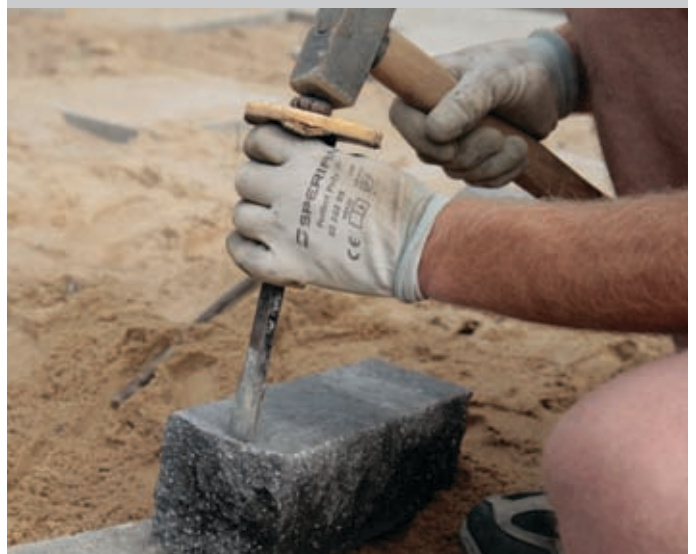
POSTARZANIE, OBIJANIE OBRÓBKA PALISADY
