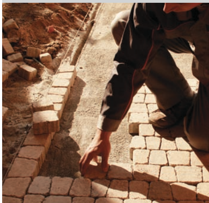
UKŁADANIE KOSTKI
