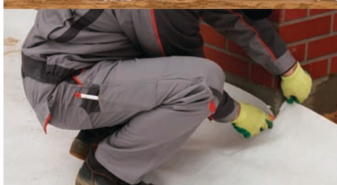
UKŁADANIE GEOWŁÓKNINY NA UBITĄ POWIERZCHNIĘ Z UWZGLĘDNIENIEM KOŁNIERZA I ZAKŁADEK
