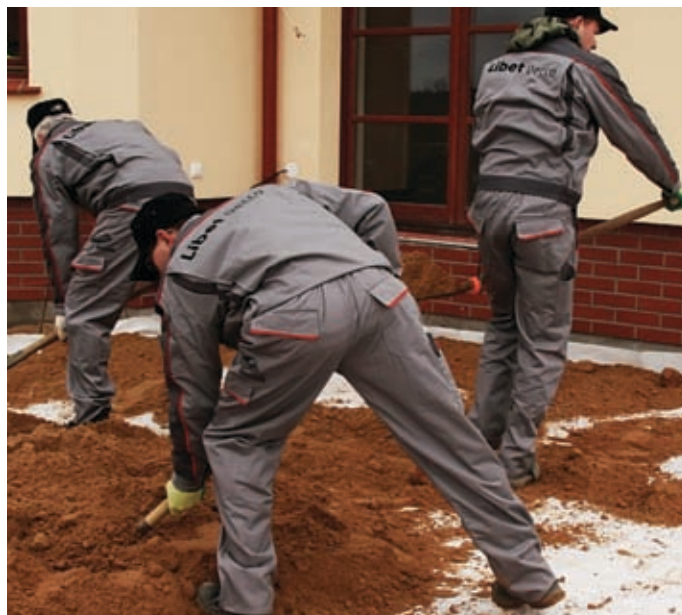
WARSTWA ODCINAJĄCA Z GRUBEGO PIASKU
