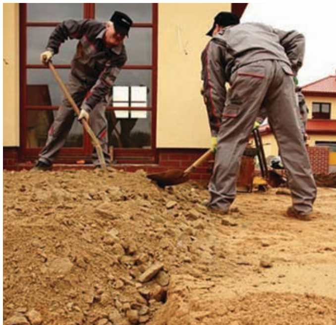
WYKONANIE PODBUDOWY I SPADKÓW TERENU
