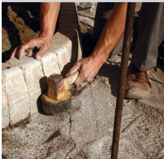
UKŁADANIE KRAWĘŻNIKA
