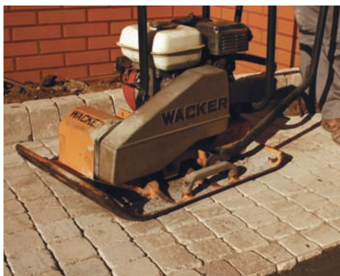
ZAGĘSZCZANIE NAWIERZCHNI
