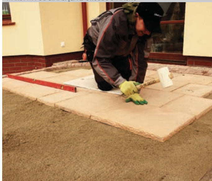
UKŁADANIE PŁYT TARASOWYCH Z ZACHOWANIEM ODSTĘPÓW OD 5 DO 15 mm
