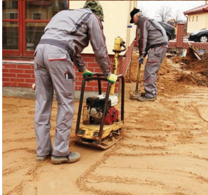
DOKŁADNE ZAGĘSZCZENIE POWIERZCHNI WRAZ ZE SPADKAMI
