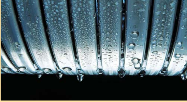
Powierzchnia grzewcza InoX-Radial: para wodna wykrapla się, oddaje ciepło... i do kanalizacji!
