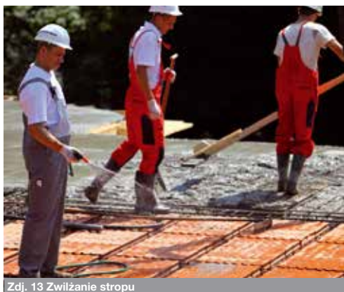
Zdj. 13 Zwilżanie stropu
