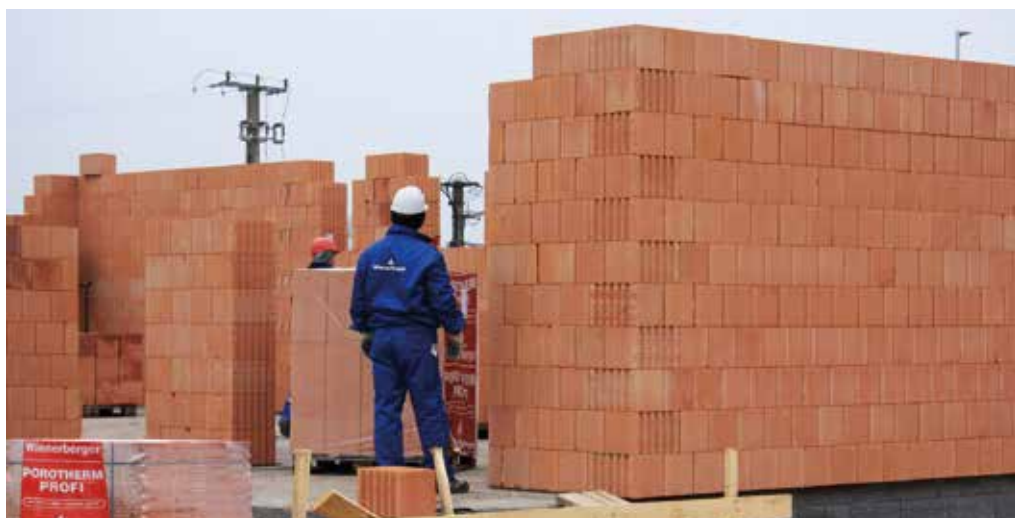
Zdj. 23 Czysta i szybka budowa w systemie Porotherm Profi
