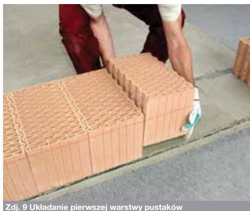
Zdj. 9 Układanie pierwszej warstwy pustaków
