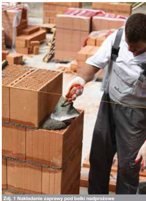
Zdj. 1 Nakładanie zaprawy pod belki nadprożowe
