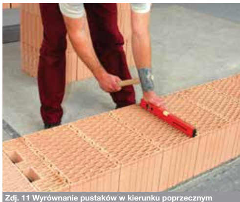
Zdj. 11 Wyrównanie pustaków w kierunku poprzecznym
