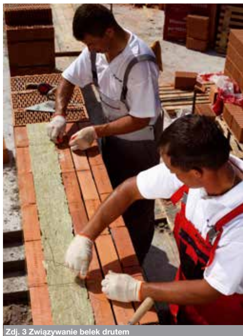
Zdj. 3 Związywanie belek drutem
