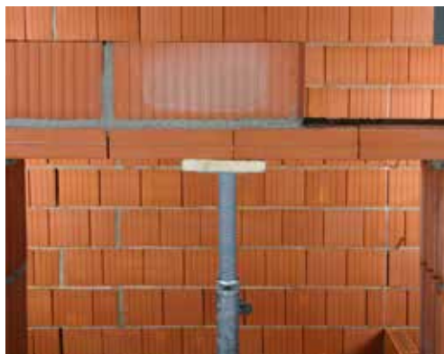
Zdj. 2 Nadproże Porotherm 11.5 na ścianie gr. 25 cm
