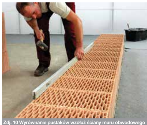
Zdj. 10 Wyrównanie pustaków wzdłuż ściany muru obwodowego
