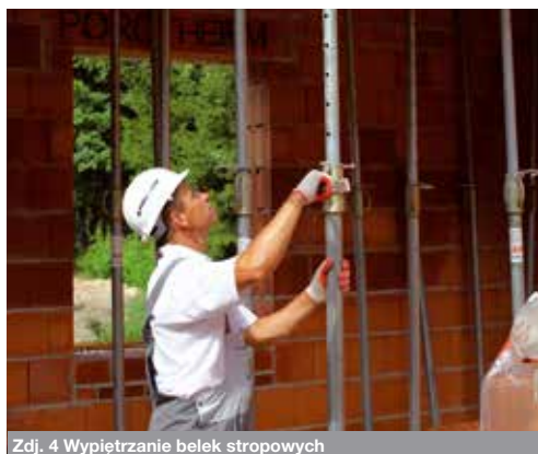
Zdj. 4 Wypiętrzanie belek stropowych
