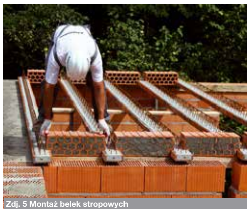
Zdj. 5 Montaż belek stropowych
