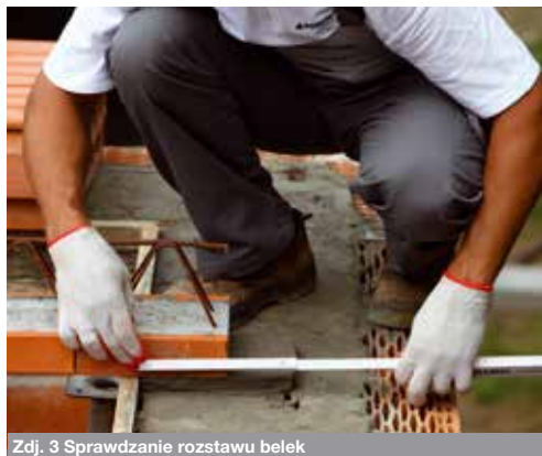
Zdj. 3 Sprawdzenie rozstawu belek
