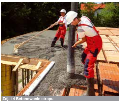
Zdj. 14 Betonowanie stropu
