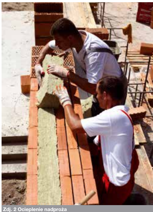
Zdj. 2 Ocieplenie nadproża
