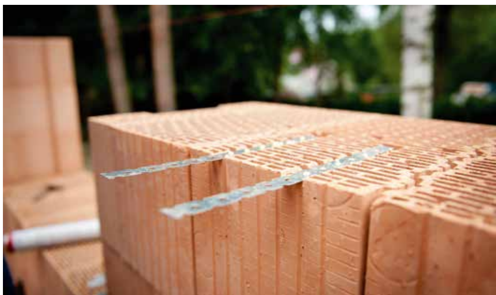
Zdj. 20 Przykład użycia kotwy w systemie cienkospoinowym Porotherm Dryfix
