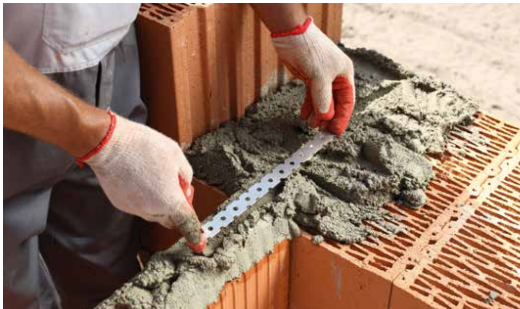
Zdj. 19 Przykład użycia kotwy w systemie tradycyjnym
