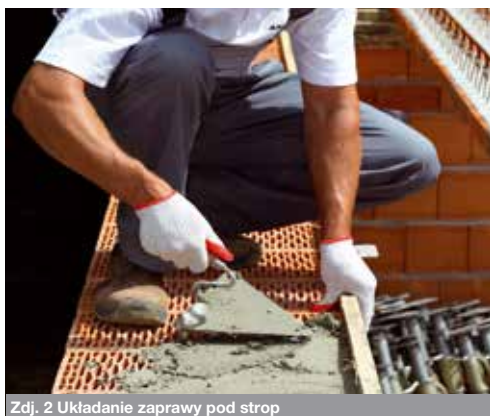
Zdj. 2 Układanie zaprawy pod strop
