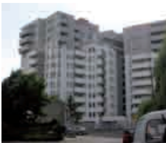
Apartamentowiec „Pelikan”, Poznań
