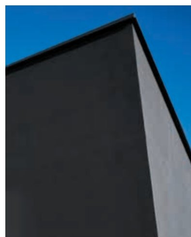
EDEKA Hieber, Bad Krozingen, Niemcy
