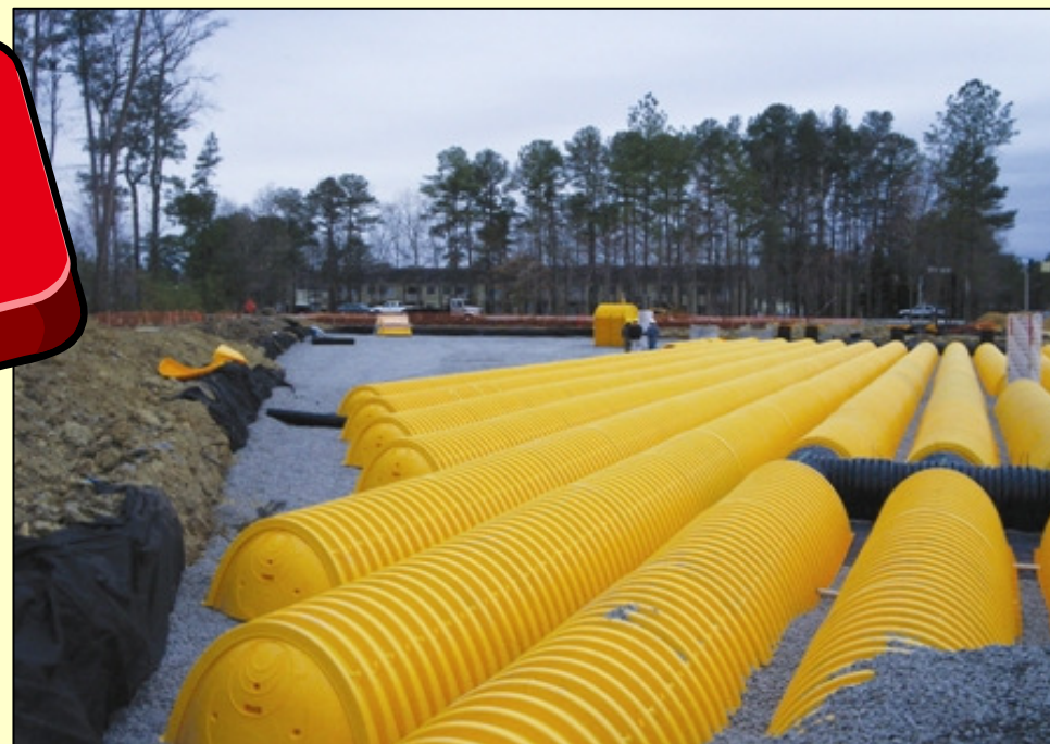
System komór drenażowych
