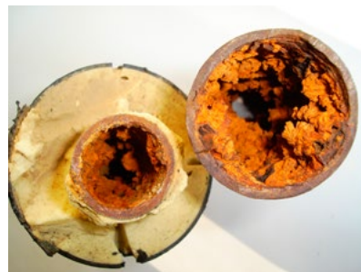
Przed montażem magnetyzerów
