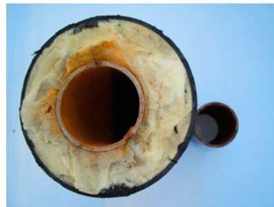
Po montażu magnetyzerów
