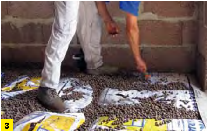
3 Przekinanie i odpowietrzanie worków
