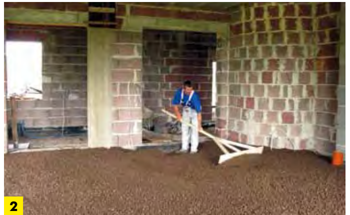
Układanie Leca® KERAMZYTU
