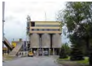
Silosy na kruszywo
