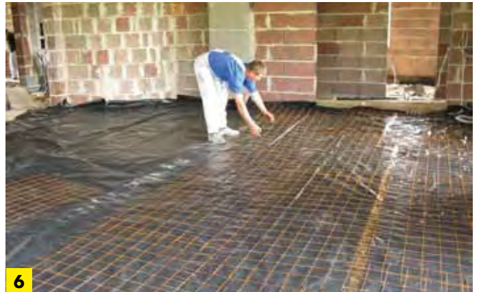
Układanie siatki zbrojenia
