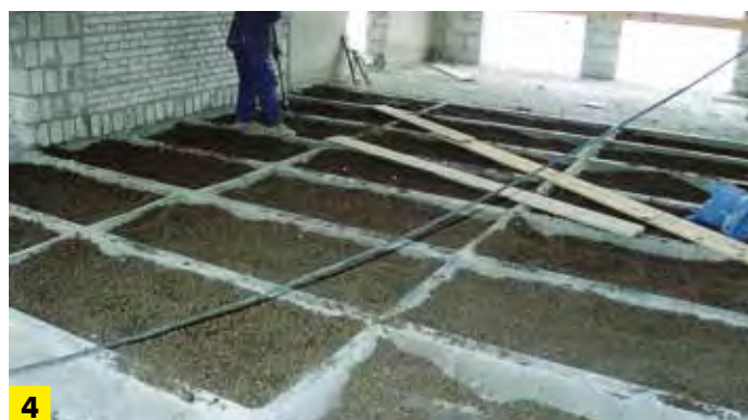
4 Wypełnienie stropu z krzyżującymi się żebrami
