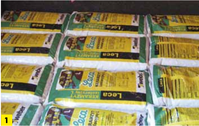
1 Układanie Leca® KERAMZYTU w workach
