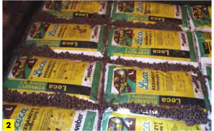
2 Zасыpywanie szczelin pomiędzy workami
