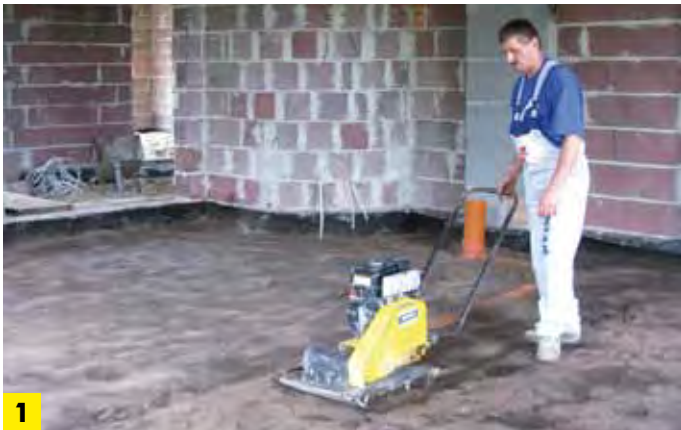
Zagęszczanie podłoża
