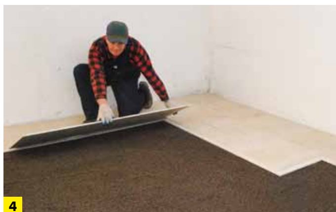
Układanie płyt suchego jastrychu
