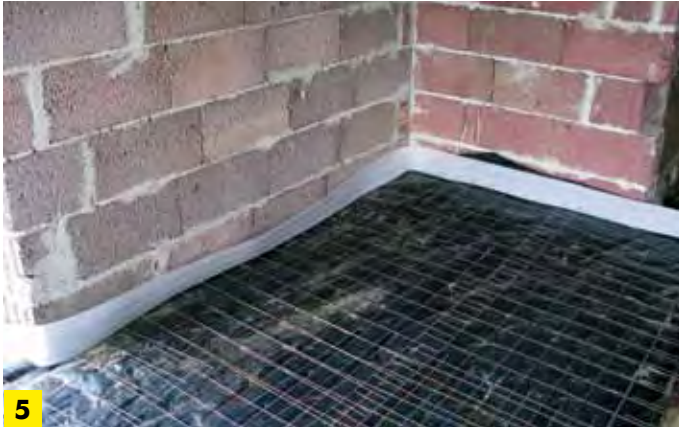
5 Układanie siatki i dylatacji obwodowej
