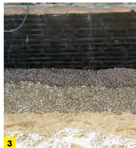
DRENAŻ - ETAP III
