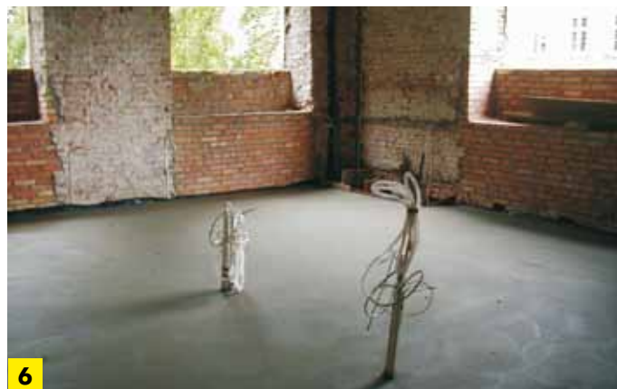
4 Wyrównane podłoże
