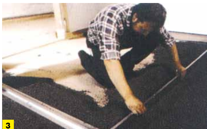
Układanie Leca® KERAMZYTU pod suchy jastrych
