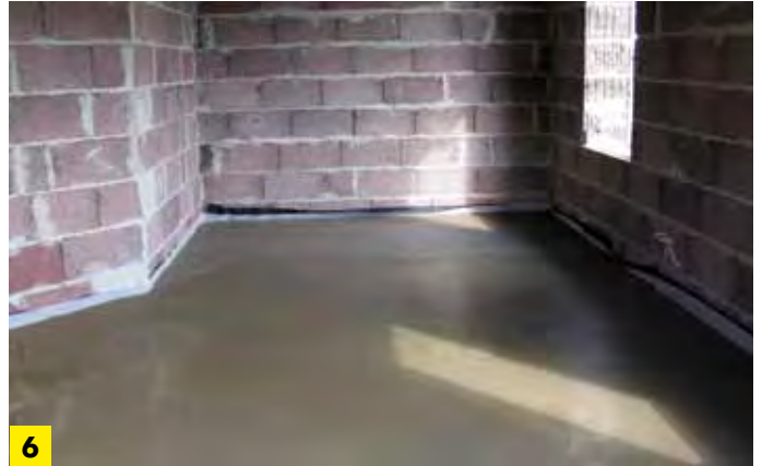
6 Gotowe podłóże na workach z Leca® KERAMZYTEM
