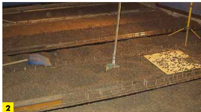
2 Wypełnienie w stropie kleina
