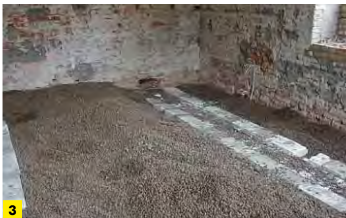
1 Stare wypełnienie na sklepieniach - piasek
