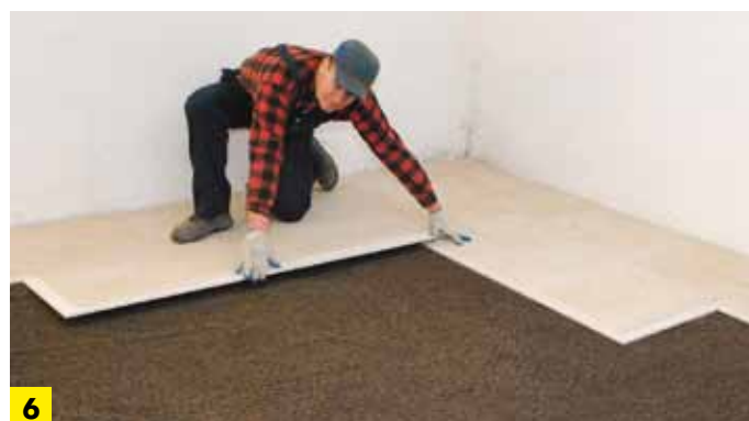
6 Układanie płyt suchego jastrychu
