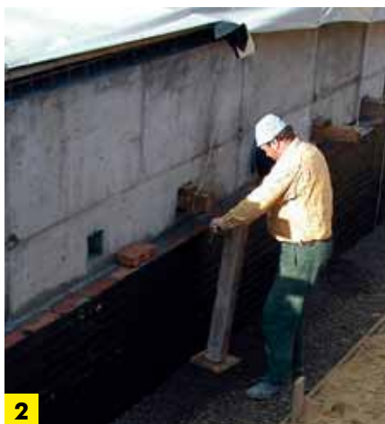
DRENAŻ - ETAP II
