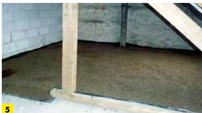
5 Izolacja na stropie poddasza
