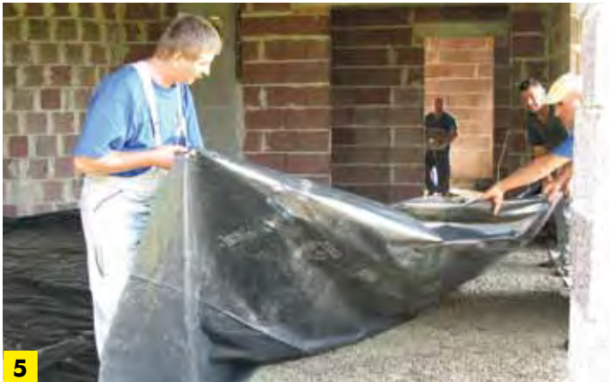
Układanie izolacji z folii
