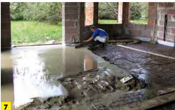
Wykonanie szlichty betonowej
