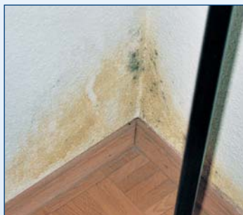
Fot.5- 6 Przykłady zawilgocenia części cokołowej budynku.
