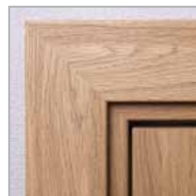
standardowe łączenie opasek pod kątem 45°
