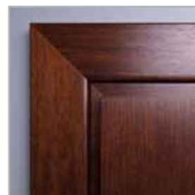
łączenie opasek pod kątem 45°
