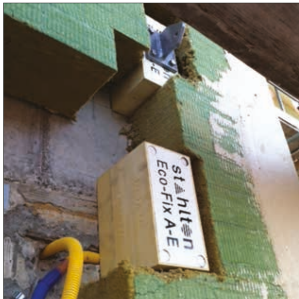
Zdj. 2 - Konsola Eco-Fix A-E do mocowania ciężkich elementów takich jak daszki, markizy, czy anteny satelitarne
