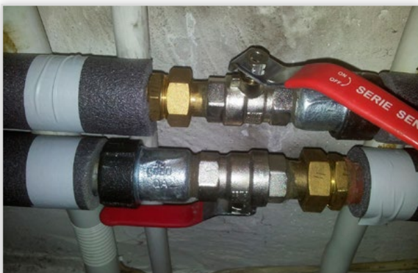
Przykład montażu złązek Gebo Quick z gwintem zewnętrznym na instalacji stalowej
