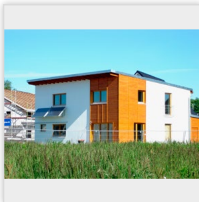
VARIOHAUS PL, 2005 r., Hamburg (Niemcy). Piętrowy budynek o prostej bryle z płaskim dachem (dom pasywny). Powierzchnia użytkowa: 160 m 2 .
