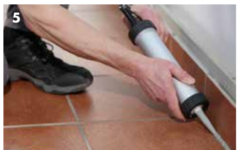
Wypełnianie spoin dylatacyjnych przy użyciu specjalnego sznura oraz elastycznej masy silikonowej ESCOSIL-2000.
