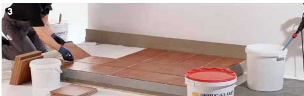
Klejenie okładzin ceramicznych metodą kombinowaną „Buttering & Floating”.
