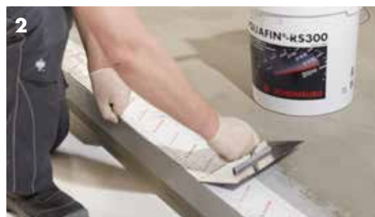
Wbudowywanie systemowej taśmy uszczelniającej ASO®-Dichtband-2000-S za pomocą AQUAFIN®-RS300 na profil zamykający balkon.
