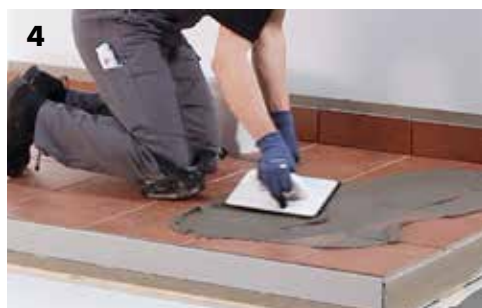
Spoinowanie okładzin ceramicznych zaprawą mineralną ASO®-Flexfuge.
