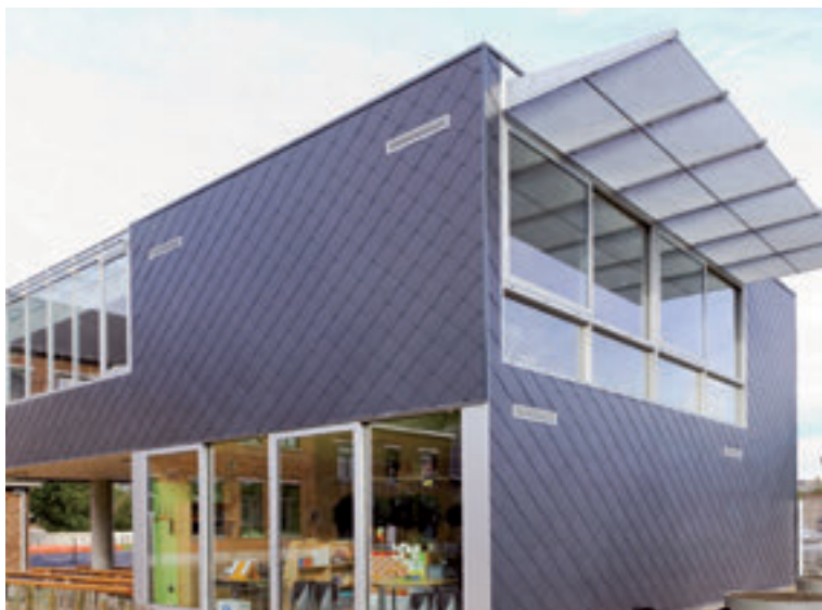
↘ Płytko dachowa i elewacyjna ALTERNA / kolor grafitowy / krycie francuskie
