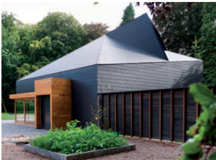
↘ Płytko dachowa i elewacyjna EURONIT / kolor grafitowy / krycie podwójne
