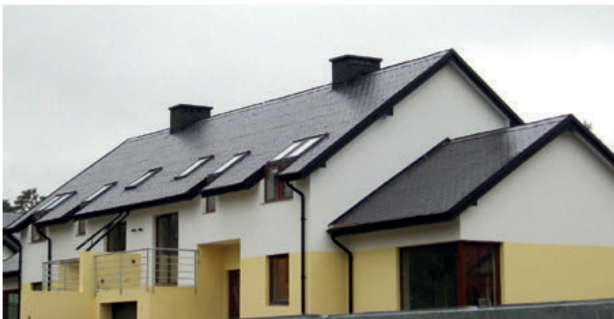
↘ Płytki dachowe i elewacyjne STRUKTONIT / kolor grafitowy / krycie niemieckie
