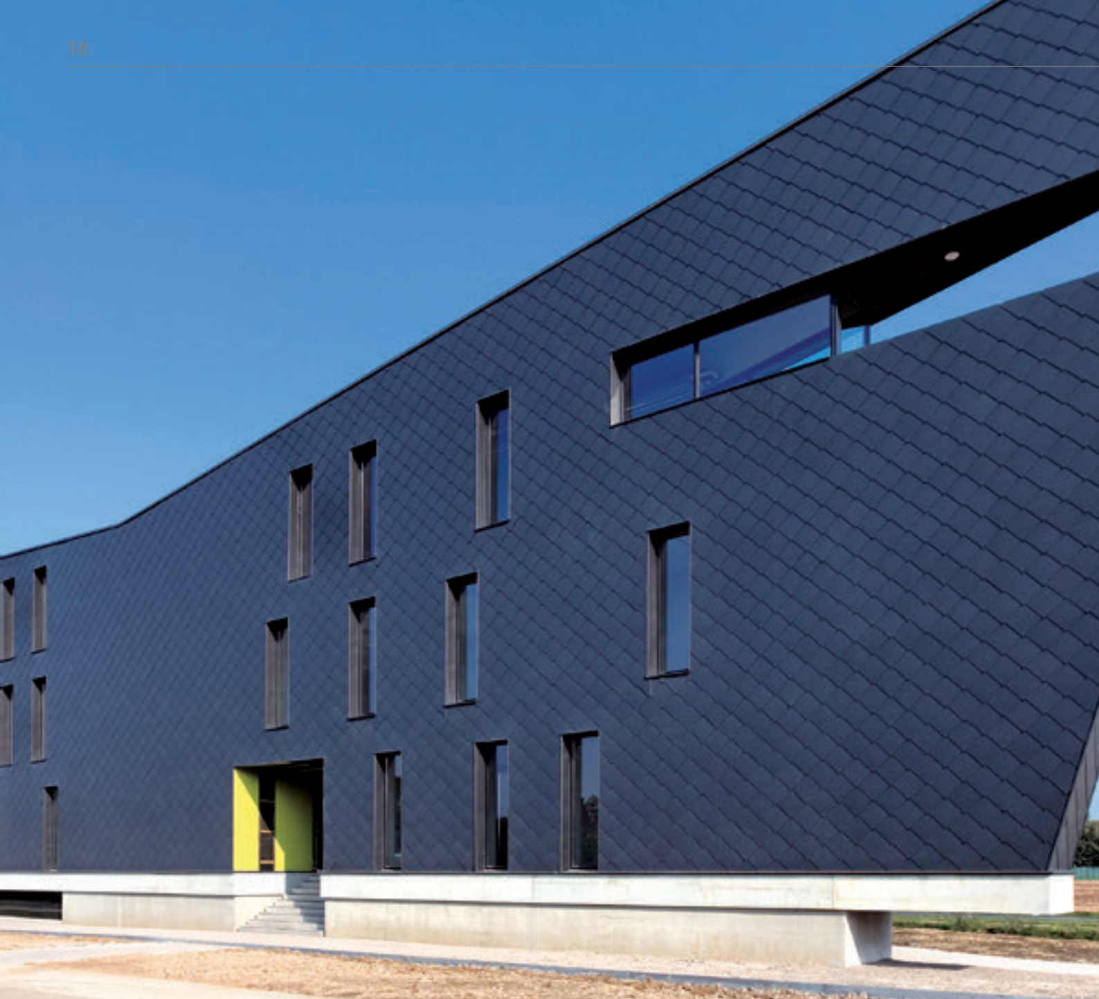
↘ Płytko dachowa i elewacyjna ALTERNA / kolor grafitowy / krycie francuskie
