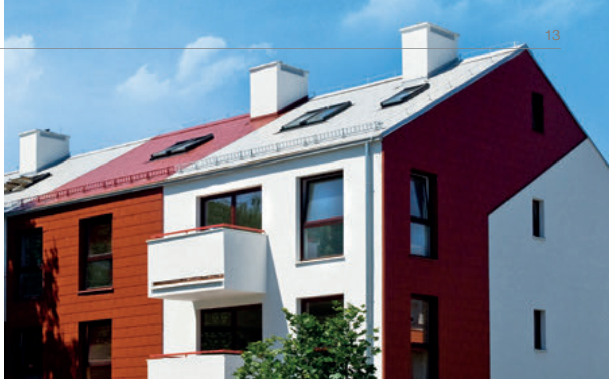
↘ Płytki dachowe i elewacyjna EURONIT / kolor ciemnoczerwony, kolor jasnoszary / krycie podwójne
