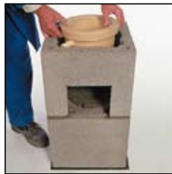
2.3 Pustak osadzić na pokrytym zaprawą cokole. Do środka włożyć kształtkę ścieku kondensatu. Ściek osadzić na zaprawie i skierować w stronę otworu.
