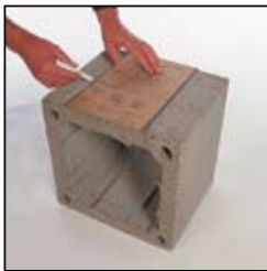
2.1 Przy pomocy szablonu (dołączony do drzwiczek) na ścianie pustaka zaznaczyć wielkość otworu do wycięcia.
