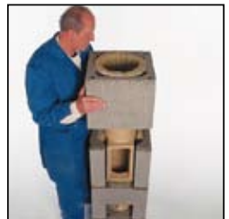
3.8 Osadzić na zaprawie pustak z wełną mineralną.
