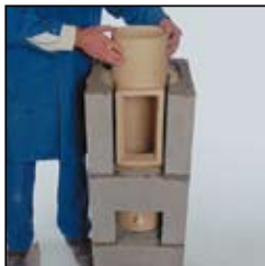
3.6 Trójkąt wyczystkowy osadzić w przygotowanym pustaku.
