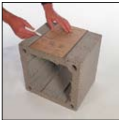
3.1 Przy pomocy szablonu (dołączony do drzwiczek) na ścianie pustaka zaznaczyć wielkość otworu do wycięcia.
