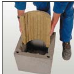
3.7 Wsunąć wełnę mineralną do kolejnego pustaka.
