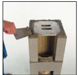
3.4 Nałożyć zaprawę montażową przy pomocy szablonu.
