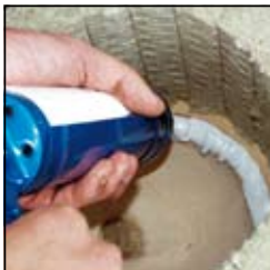
3.5 Na oczyszczoną krawędź naczynia na kondensat nałożyć kit kwasoodporny.
