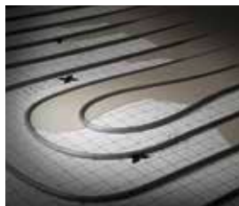
Doskonale nadaje się do wylewek płynnych – dzięki solidnie połączonym panelom masa wylewki dociska rury ku dołowi
