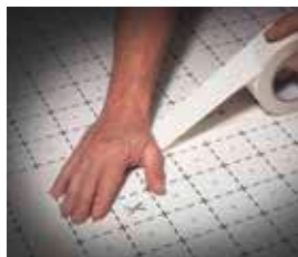
Doskonale nadaje się do wylewek płynnych – dzięki solidnie połączonym panelom masa wylewki dociska rury ku dołowi
