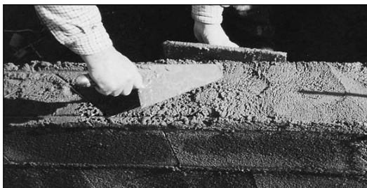
Rozłóż warstwę zaprawy.
