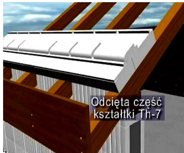
Rys.63 Układanie części okapowej elementu TH-7
