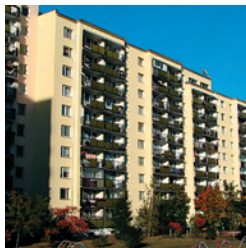
Budynki Spółdzielni Mieszkaniowej Lazurowa w Warszawie. Zastosowano system ispotherm A+C
