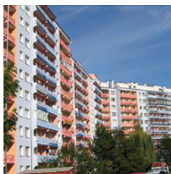
Budynki Spółdzielni Mieszkaniowej Podzamcze w Wałbrzychu. Zastosowano system ispotherm B
