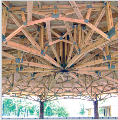
Tartak Witkowsky, Lonżownik . Konstrukcja dachu: łączona na płytki kolczaste. Lokalizacja: okolice Warszawy.
