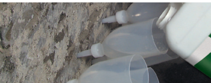
Włożyć lejki i wlać SUCHY MUR ULTRAMENT
