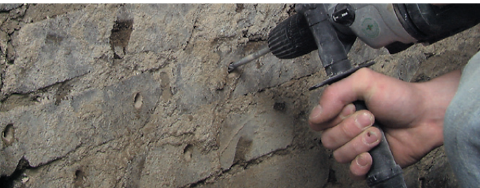
Wykonać otwory w ścianie
