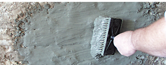
Otynkować ZAPRAWĄ USZCZELNIAJĄCĄ ULTRAMENT
