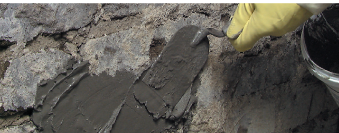
Otwory wypełnić ZAPRAWĄ USZCZELNIAJĄCĄ ULTRAMENT
