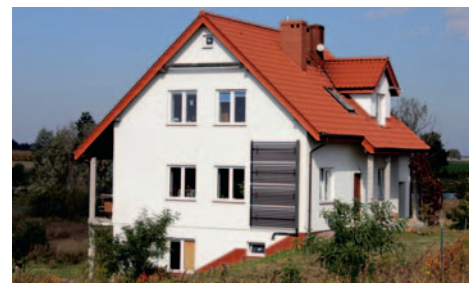
▲ Rys. 3. Zastosowanie kolektorów próżniowych KSR10 jest możliwe również w nietypowych warunkach zabudowy, przy niekorzystnym usytuowaniu połaci dachu
