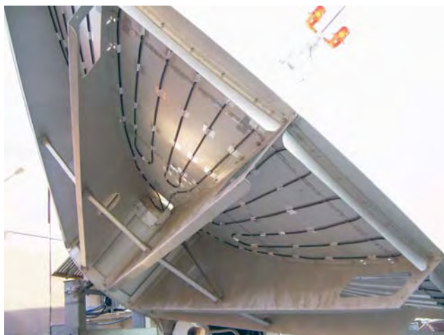
Ochrona przed śniegiem i lodem czaszy anteny satelitarnej
