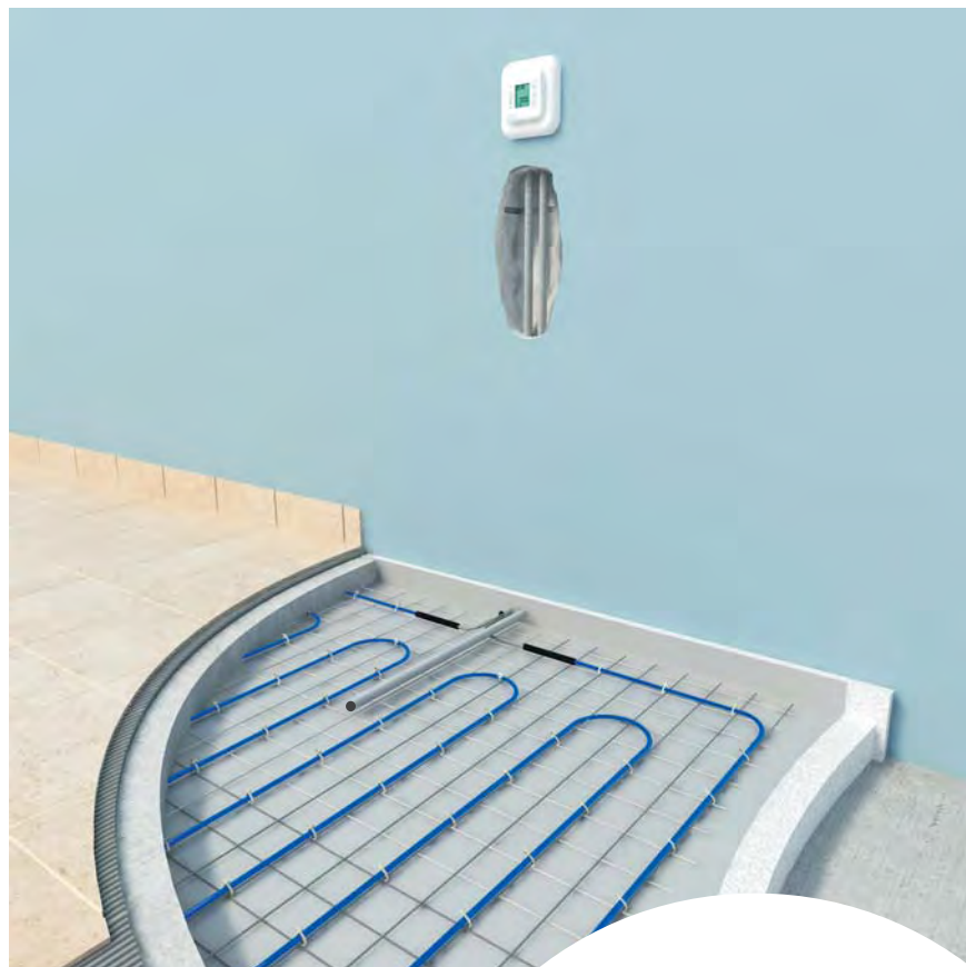
Mocowanie przewodu grzejnego ELEKTRA VC do siatki metalowej
