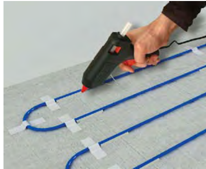
Klejenie przewodu grzejnego do podłoża za pomocą kleju na gorąco
