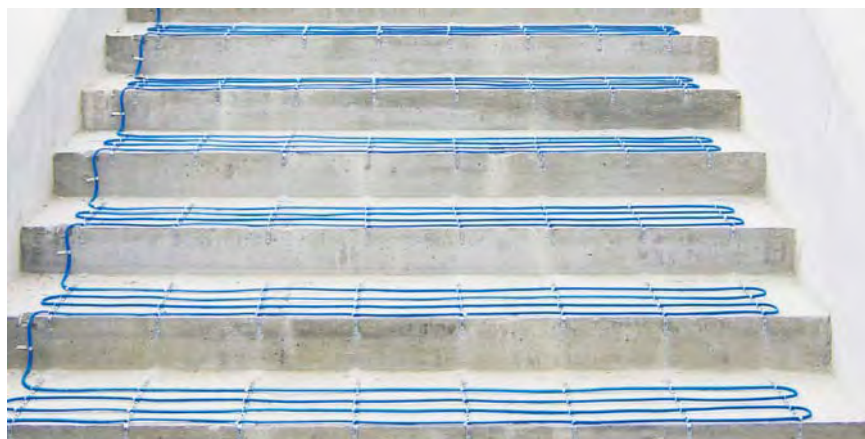
Ułożenie przewodów grzejnych
