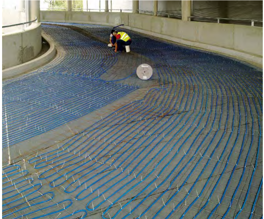
Mocowanie przewodu grzejnego do siatki montażowej
